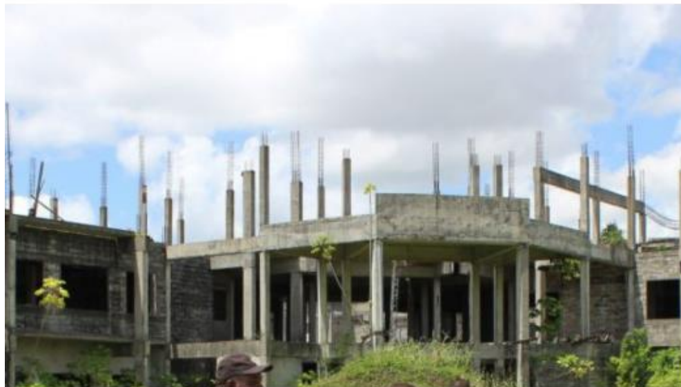
Het in aanbouw zijnde hoofdbureau van het Korps Politie Suriname. Foto NII
