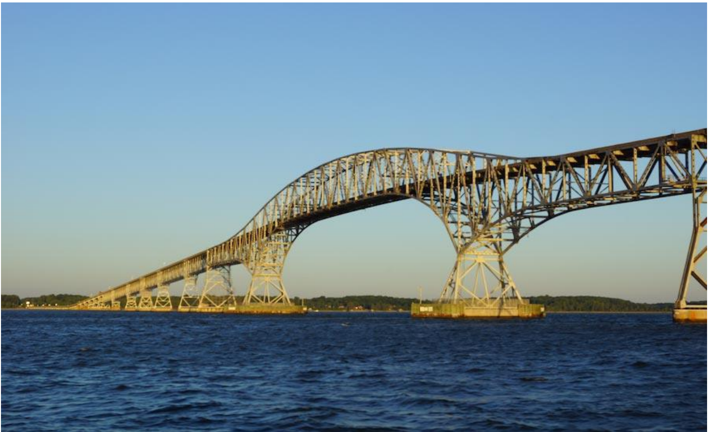
Figure 77 Brug over de Corantijnrivier
